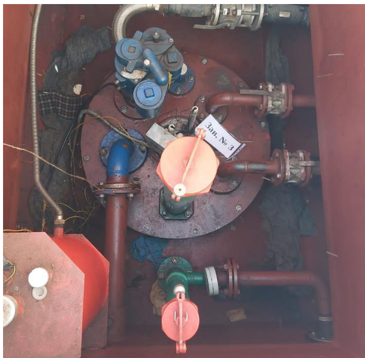
Рисунок 3 – Горловина резервуара РГС-63 зав.№ 3
